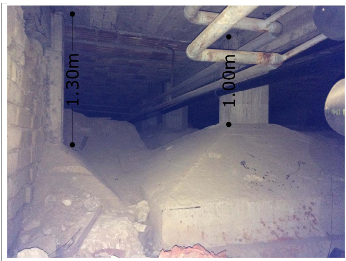
Figura 5.10 Misurazione pilastri al di sopra dei plinti
