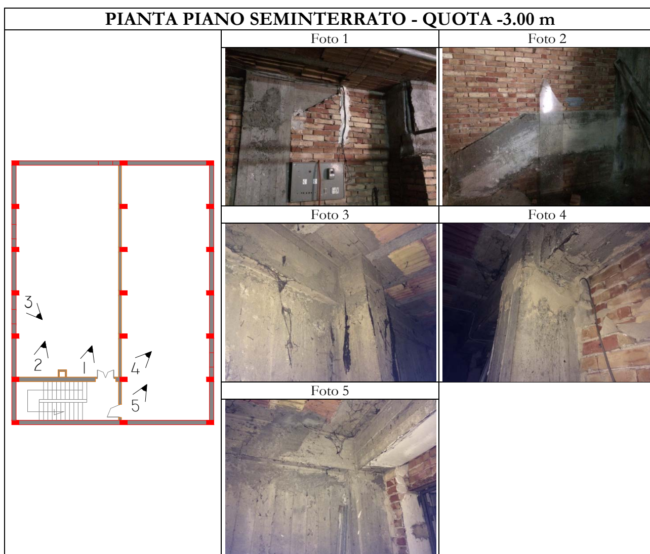
Figura 5.5 Rilievo fotografico piano seminterrato
