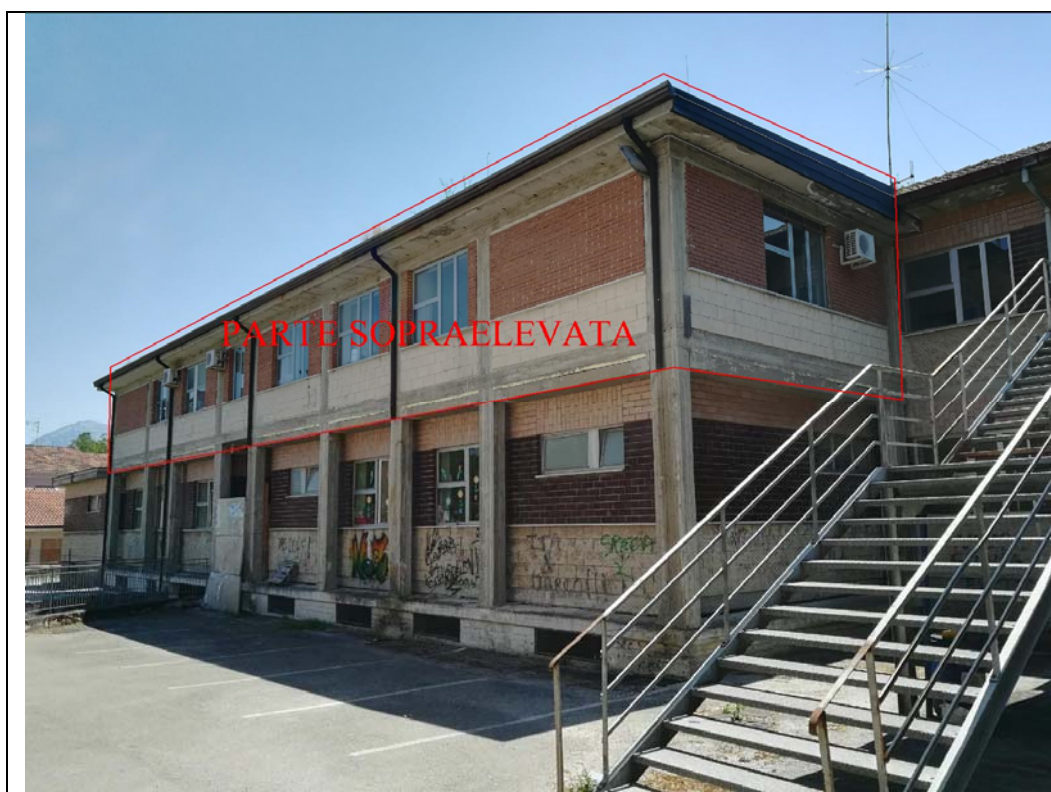
Figura 7.4 Vista esterna del fabbricato con indicazione della parte sopraelevata
