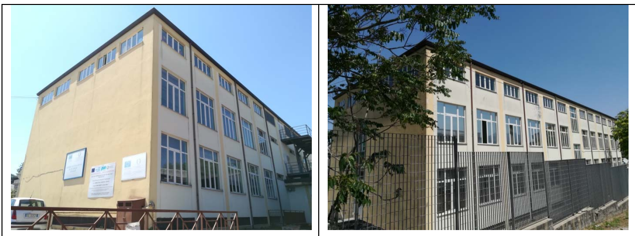
Figura 3.2 Scuola elementare Mazzetti
