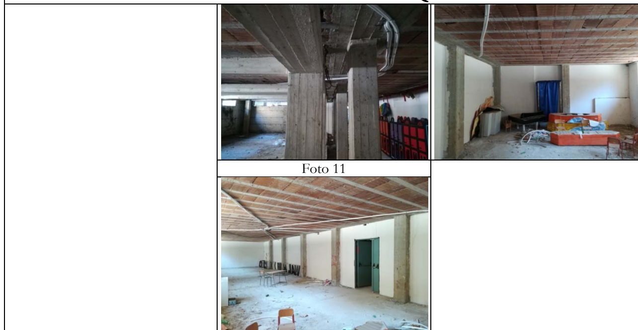
Figura 7.5 Rilievo fotografico piano seminterrato
