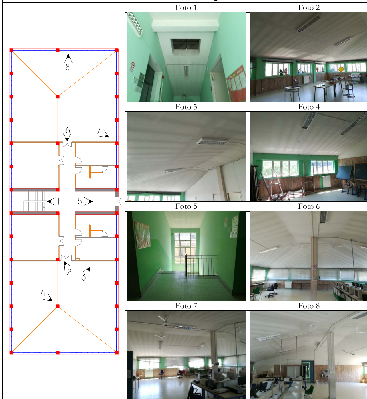
Figura 6.5 Rilievo fotografico piano sottotetto
